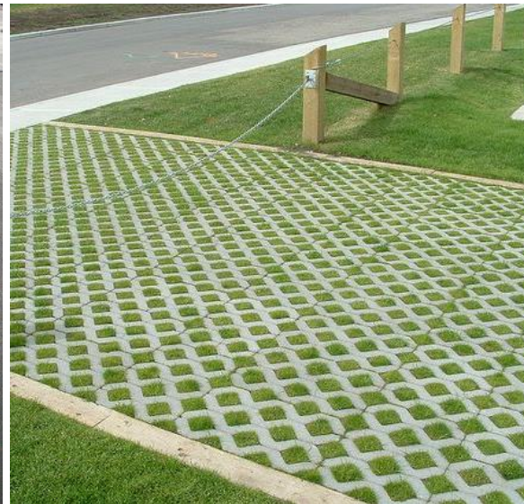
PAVAGE BÉTON ENHERBÉ
